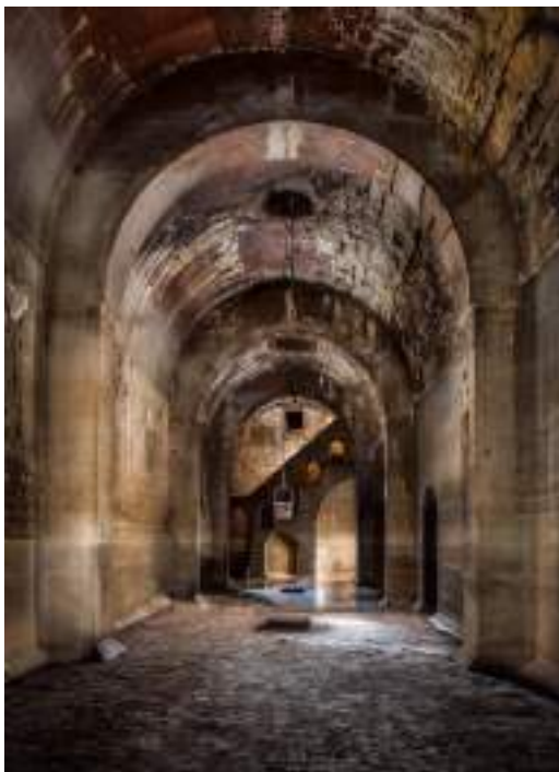
Fig. 5. Interior del aljibe de Tendilla en el recinto de la Alhambra. Escalera de acceso situada en la cara norte cegada posteriormente a su construcción en el siglo XV. Granada, Patronato de la Alhambra y Generalife.
