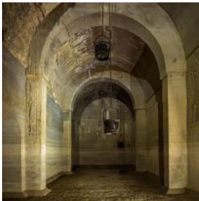
Fig. 7. Interior del aljibe de Tendilla en el recinto de la Alhambra. Se pueden apreciar las lumbreras abiertas en las bóvedas y actualmente tapadas por las que se introducían los calderos de madera sujetos por cadenas metálicas para extraer el agua desde los brocales exteriores. Granada, Patronato de la Alhambra y Generalife.
