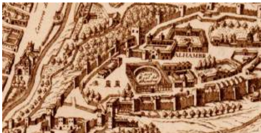
Fig. 9. Ambrosio de Vico, Detalle de la Plataforma de la Ciudad de Granada, c. 1590 (Grabado por Francisco Heylan, 1613). En el grabado se observa la planicie que unía la portada del Emperador del palacio de Carlos V (Casa Real del Alhambra) con la explanada de los aljibes casi colmatada. Se aprecian los dos brocales para extraer agua del interior del aljibe de Tendilla que se conservaban entonces. Granada, Archivo Histórico Municipal del Ayuntamiento de Granada (AHMGR). Fondo fotográfico/Signatura: 00.017.01.
