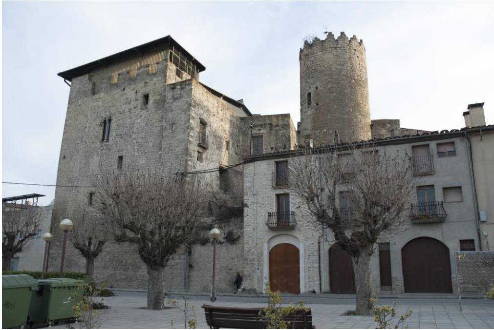
Fig. 5 – Santa Coloma de Queralt. Castillo, fachada lateral (Santa Coloma de Queralt, Conca de Barberà -Tarragona-). Fotografía Joan Fuguet.
