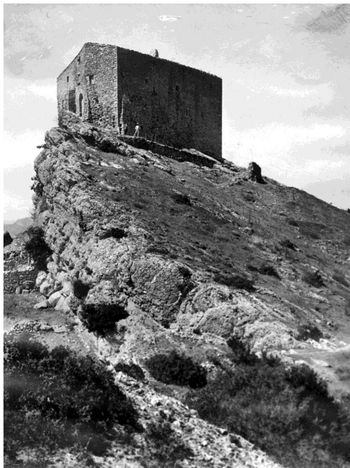
Fig. 3 – Castillo de Queralt en 1918 (Bellprat, Anoia -Barcelona-) Fotografía Català Pic.
