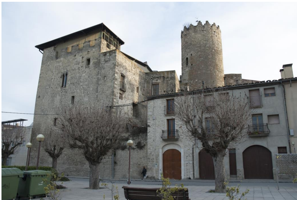
Fig. 5 – Santa Coloma de Queralt. Castillo, fachada lateral (Santa Coloma de Queralt, Conca de Barberà -Tarragona-). Fotografía Joan Fuguet.
