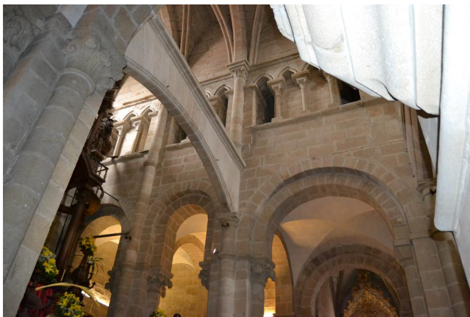
Fig. 5 - Interior del transepto la catedral de Tui. Fuente: foto del autor.
